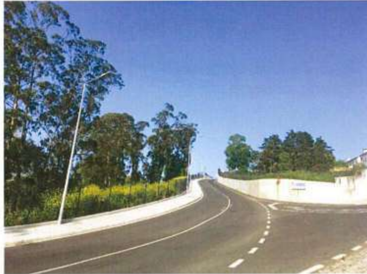
Prolongamento da Rua do Castelo
