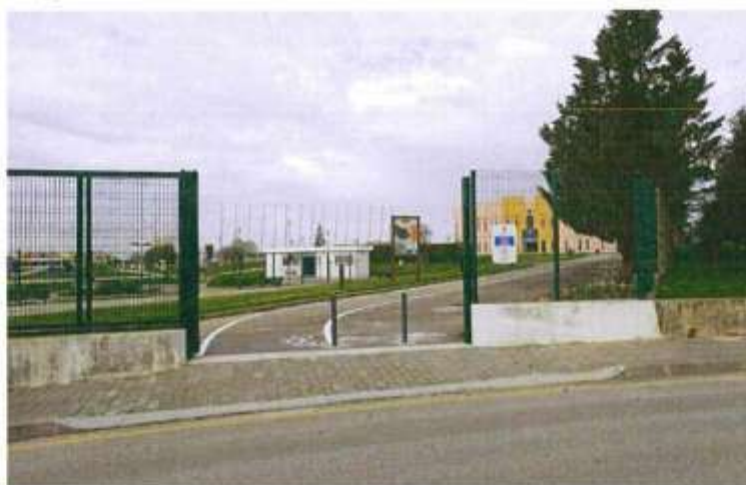
Acesso junto ao Parque Intermodal de Mafra
