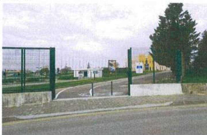
Acesso junto ao Parque Intermodal de Mafra
