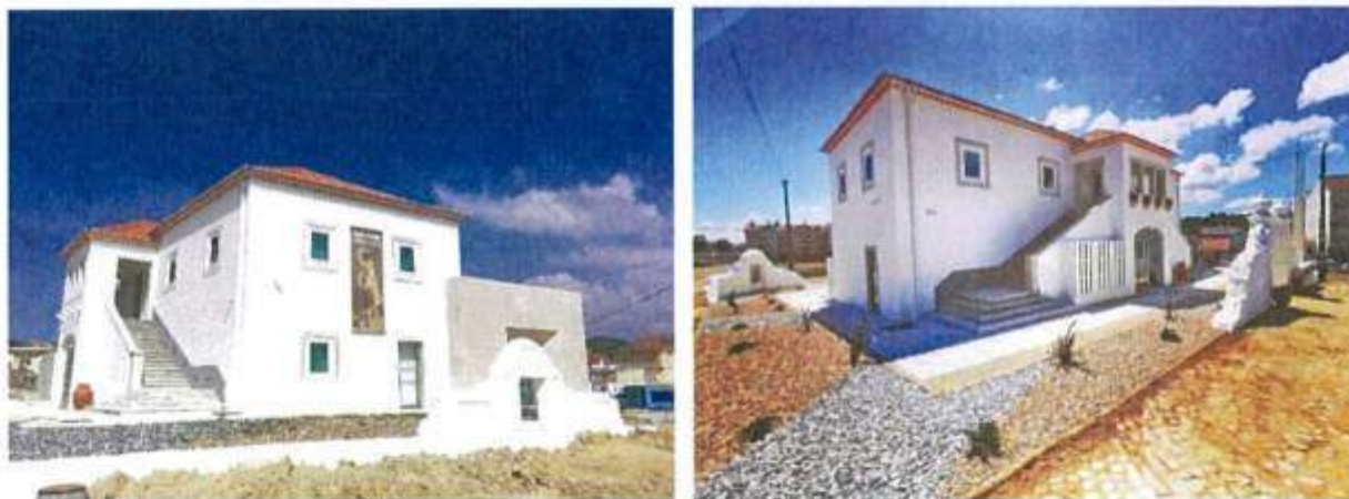
Exterior do Edifício
