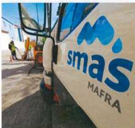
REPARAÇÃO DE AVARIAS
