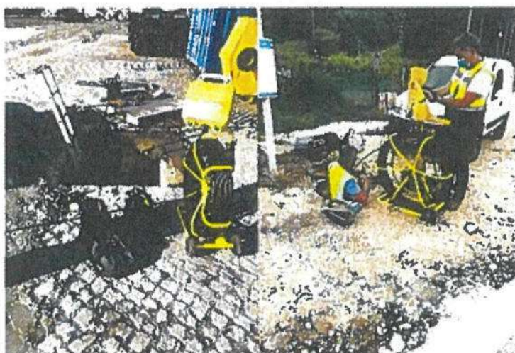
Figura 3 - equipamento de sondagem com CCTV incorporado para inspeção e deteção de infraestruturas
