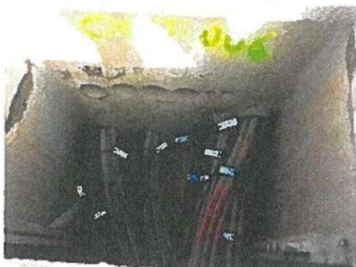
identificação e etiquetagem de cabos elétricos e telecomunicações
