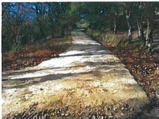
Requalificação de vias de acesso interno (Anel Norte)
