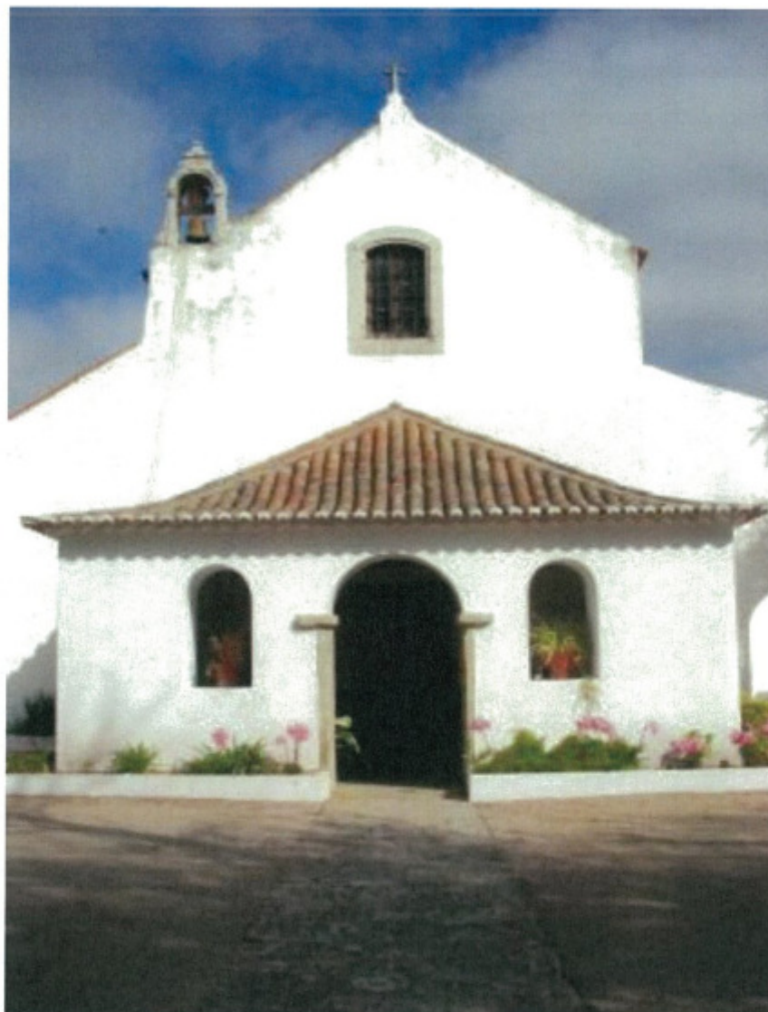
Figura 4 – Igreja da Nossa Sra. Dos Remédios, Malveira
