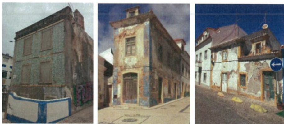
Figura 49 | Estado de conservação: mau e péssimo Fonte | Estudos de Caracterização | Fichas do edificado
