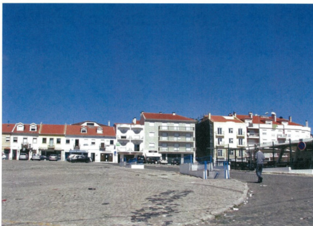
Figura 10 – Largo da Feira da malveira (entradas para as instalações)
