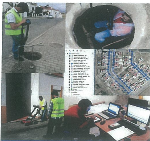
Equipa Municípia em várias fases de atividade de cadastro das redes de água em Castro Verde com evidência de uso de várias tecnologias
