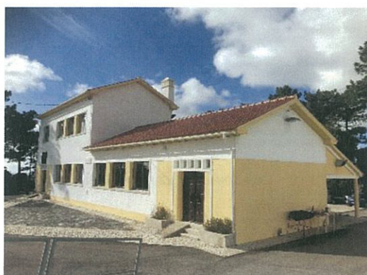
Foto 11 – Escola Básica do Sobreiro
