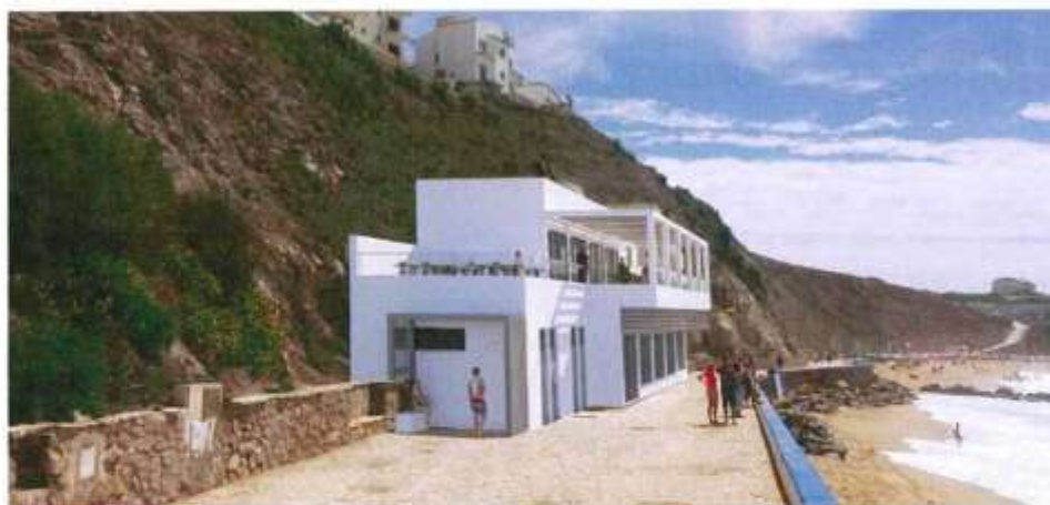
Apoio de Praia - Praia da Bateria/ Sul
