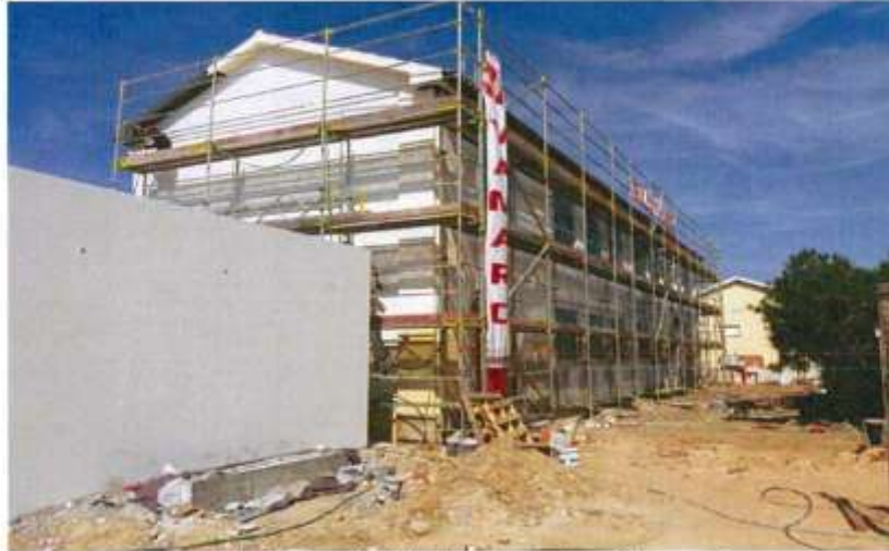
Futuras Instalações da GNR do Livramento - Obra em Curso
