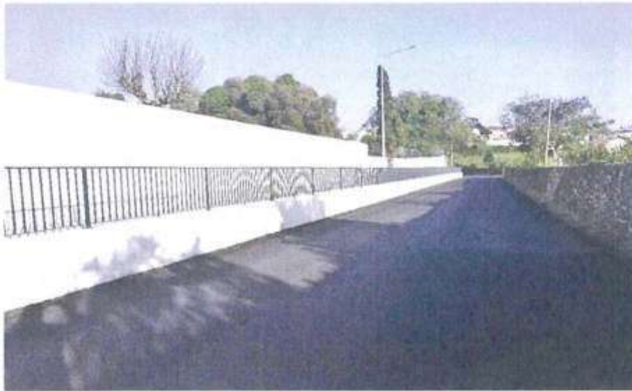
Passeio Pedonal - Rua do Malvar
