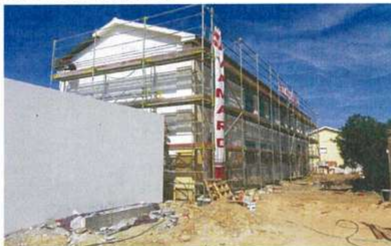
Futuras Instalações da GNR do Livramento - Obra em Curso
