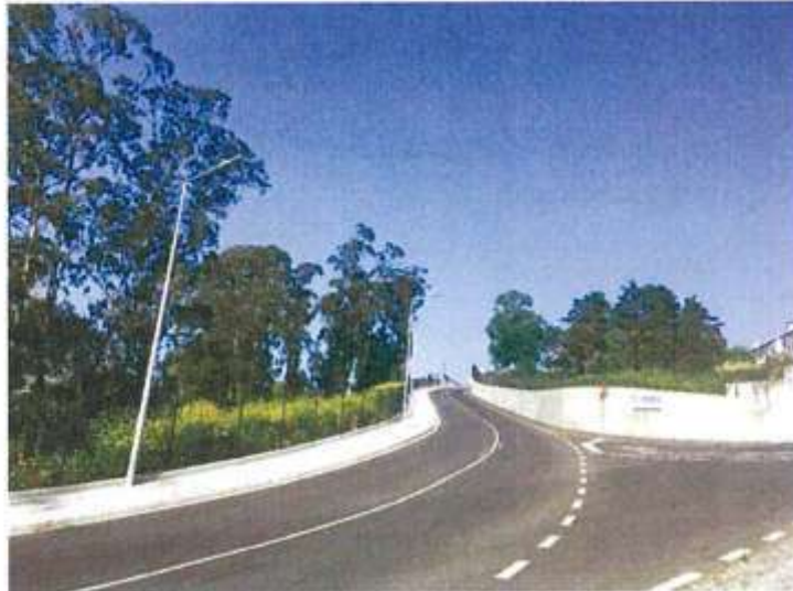
Prolongamento da Rua do Castelo
