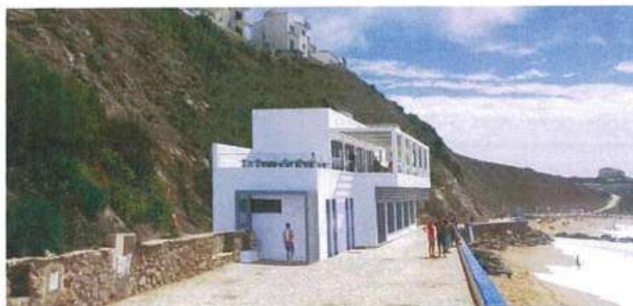
Apoio de Praia - Praia da Baleia/ Sul
