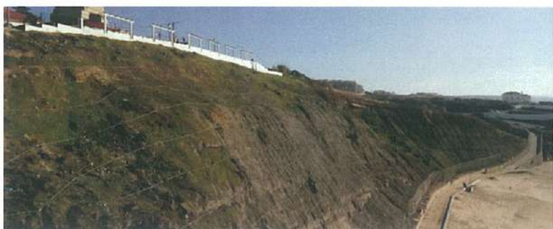
Vista panorâmica após execução os trabalhos
