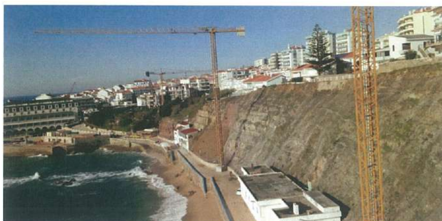
Panorâmica da zona norte da arriba após execução os trabalhos de estabilização
