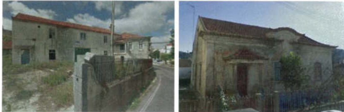
Figura 33 | Edifício Histórico em estado de degradação – Malveira.
